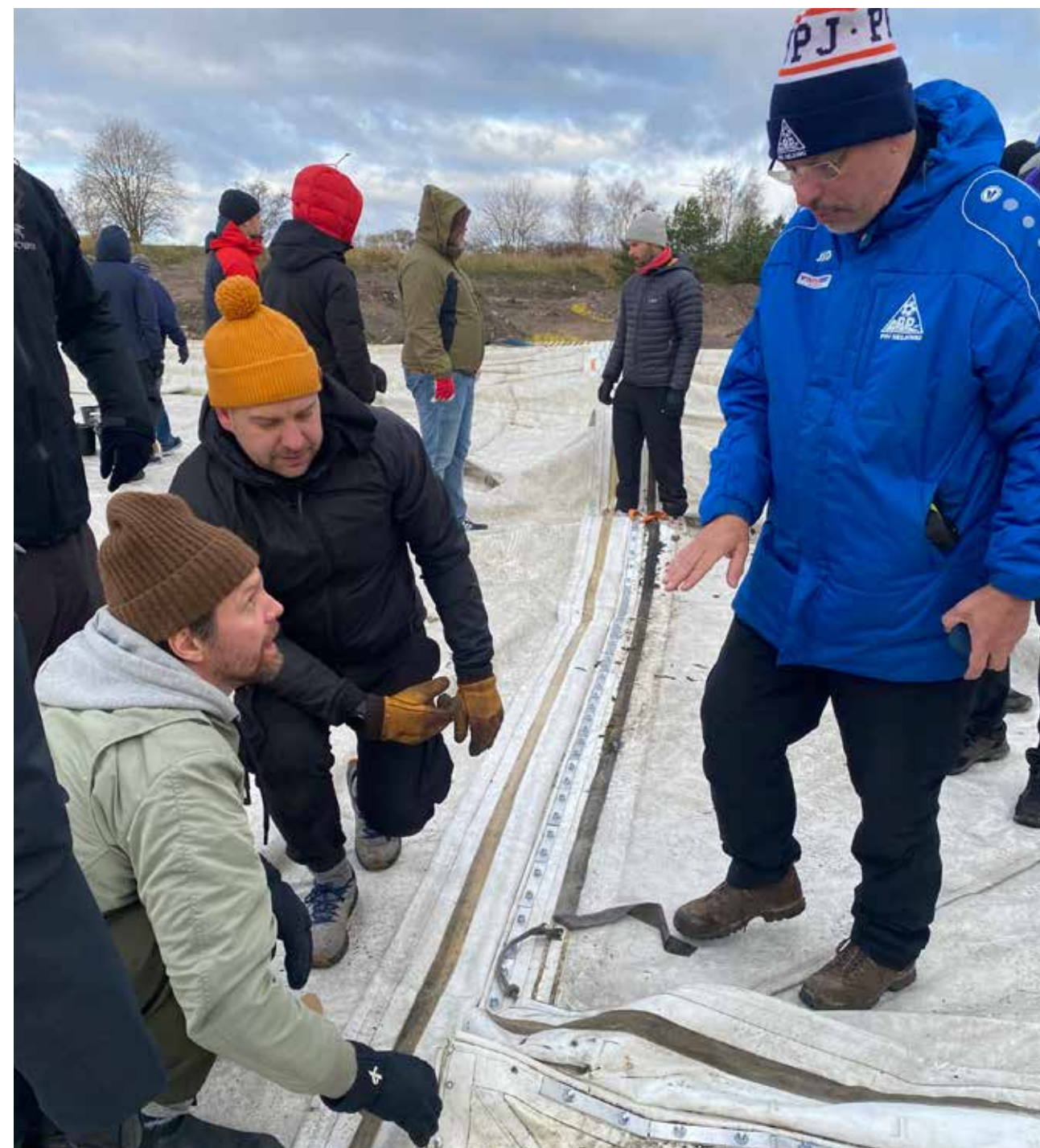
Timo Drachman tarkasteli lopputulosta, kun kankaiden liitoskohtien viimeisiä pultteja oltiin kiinnittämässä.
